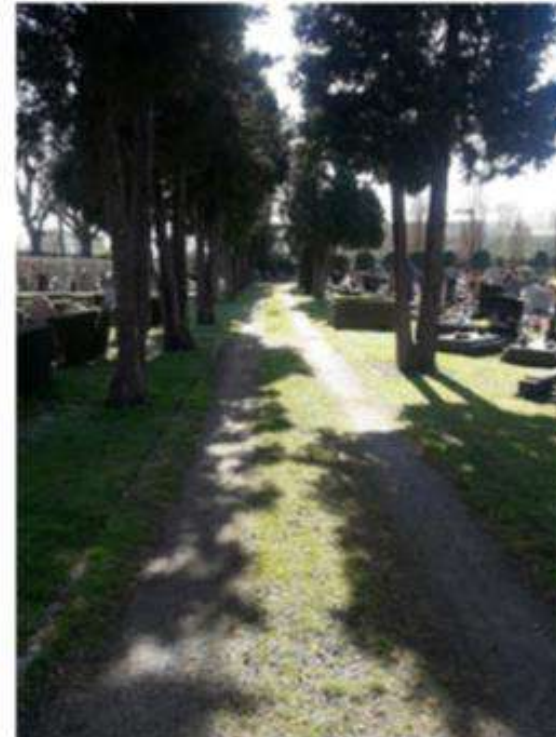
Situation après : revêtement en mélange terre-pierre engazonné et perméable
